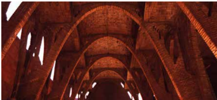
El Celler cooperatiu de Sant Cugat, obra de Cèsar Martinell. Fotografia: CCVOC
