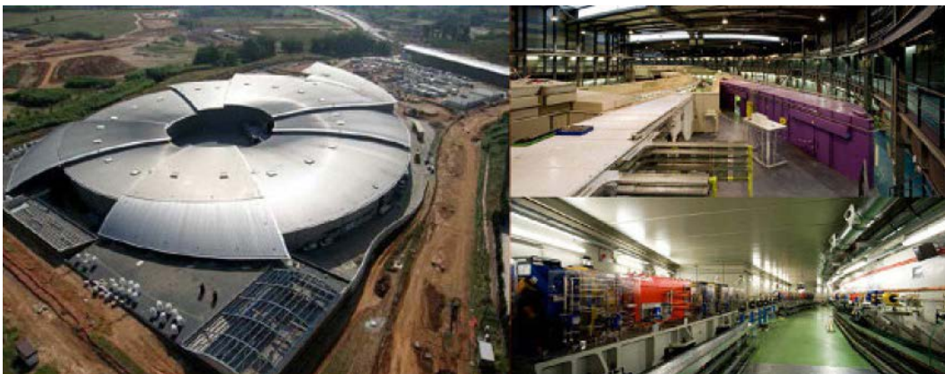
Instal·lacions del Sincrotró Alba
